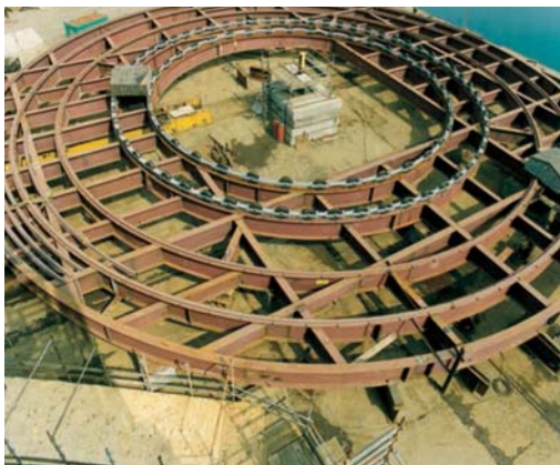
Chimeneas giratorias. Ruedas motrices de \phi 300\text{mm} . con núcleo de acero y banda de Vulkollan®, y eje sujeto con chaveta.
